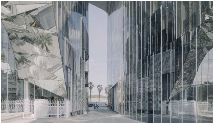
La Torre del Gas de Barcelona es aún hoy uno de los edificios más conocidos de la ciudad
